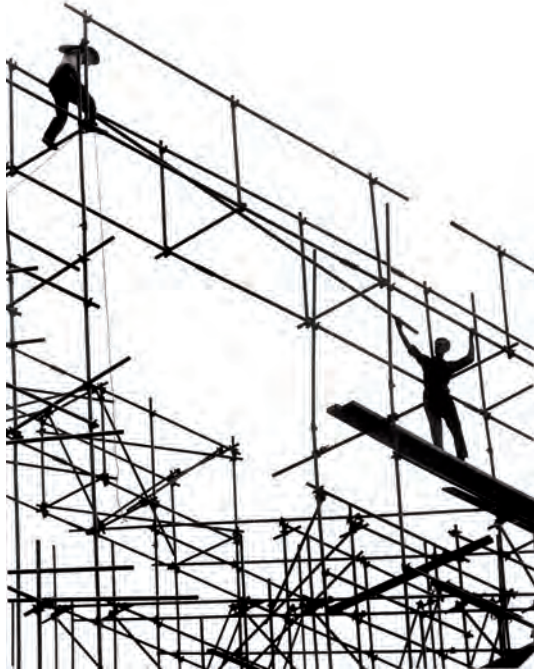
Hans Silvester Stahlgerüstmontage, ca. Ende der 1950er Jahre © Hans Silvester / Leica Camera AG
